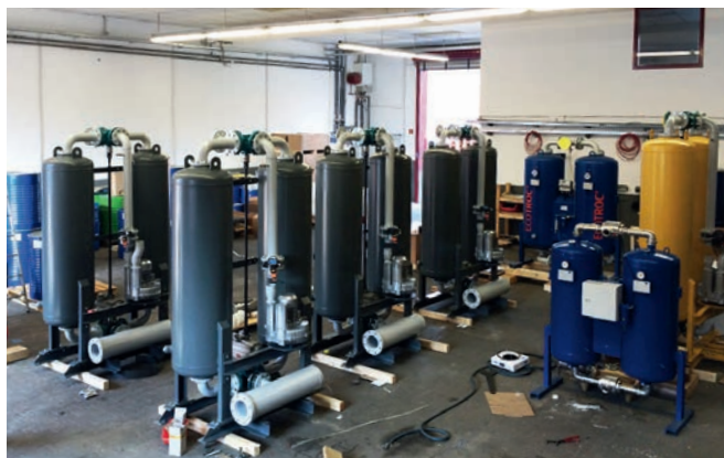
Montage ATW-V und weiterer Trockner in den alten, beengten Räumlichkeiten
