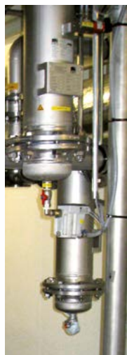
Filtro bridado, diseño de acero inoxidable
